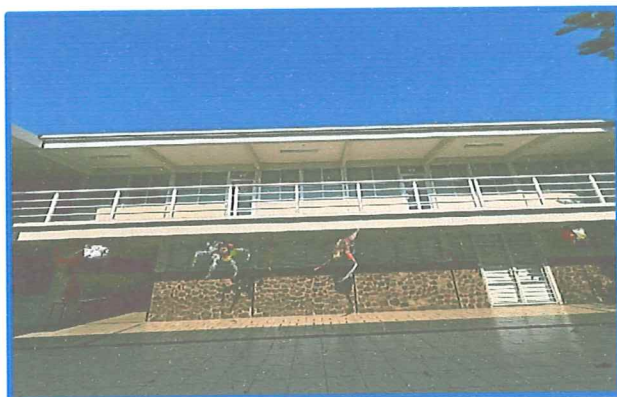
Fachada Principal del Edificio B.
