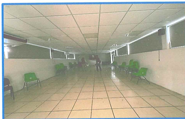
Área interior del Edificio B.
