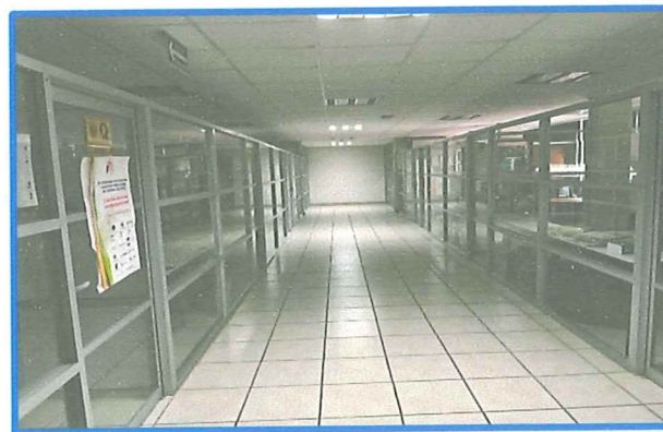
interior del edificio educación continua y a distancia.
