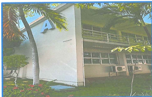
Fachada Posterior del Edificio A.
