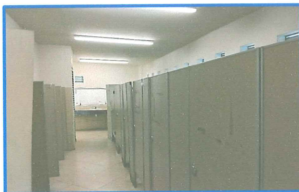
Área interior de sanitario mediano.
