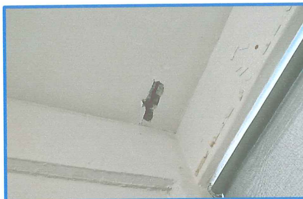
Exposición del acero de refuerzo en el edificio D.
