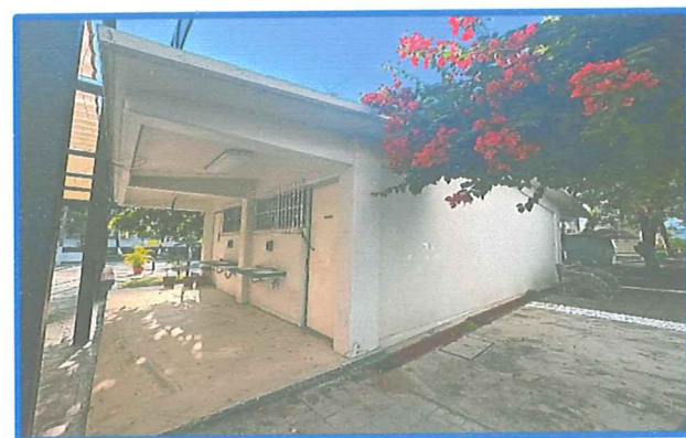
Fachada Principal de sanitario (pequeño).
