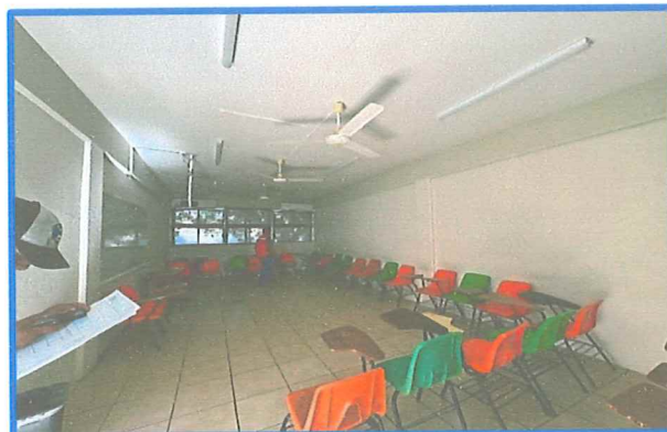
Área interior del Edificio A.
