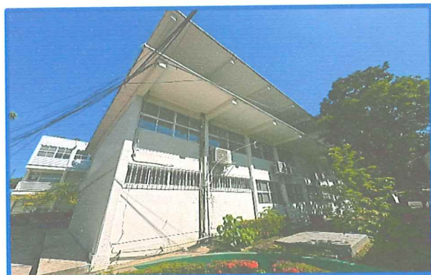
Fachada Posterior del Edificio E.
