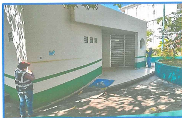
Fachada Posterior de sanitario mediano.
