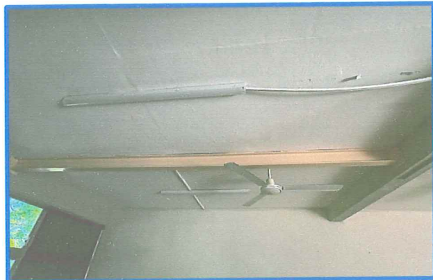
Refuerzo en losa del edificio A (A8 y A9) mediante perfil IR, debido a una deflexión.
