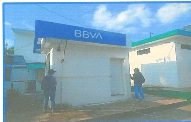
Fachada lateral de módulo de cajero.
