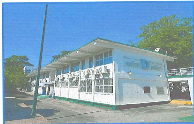
Fachada Posterior del Edificio D.
