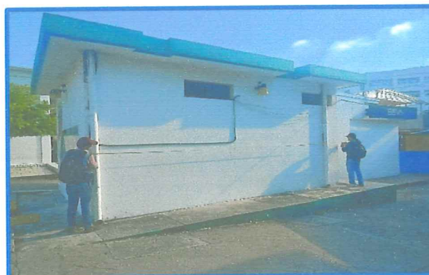
Fachada posterior de módulo de subestación.
