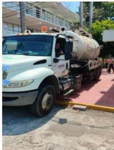
Colector hidrosanitario en DAEA
