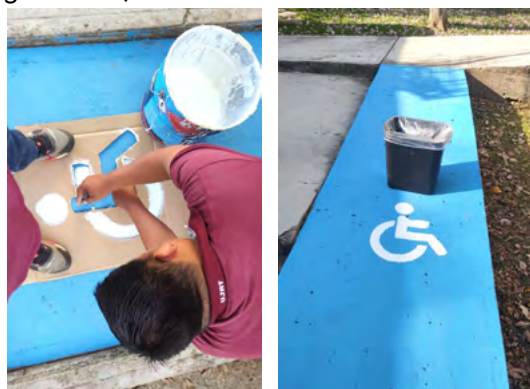
Figura 104. Rehabilitación de Rampas
