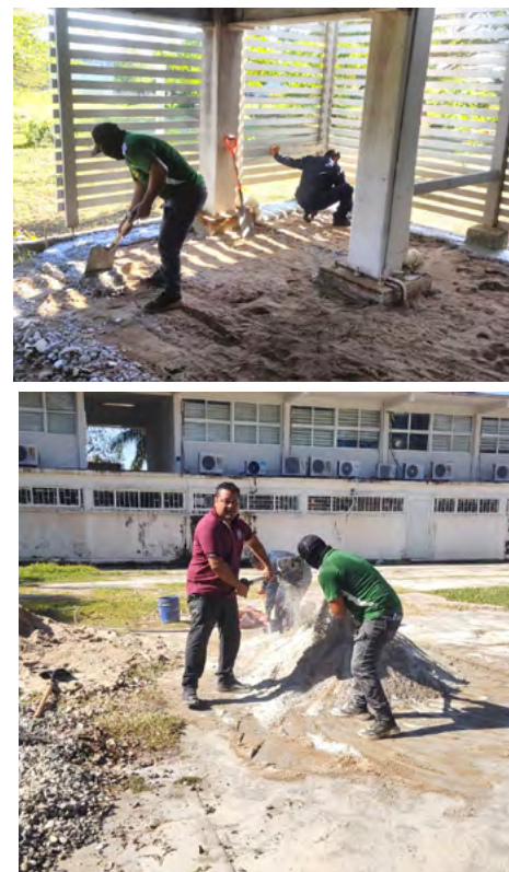
Figura 105. Rehabilitación del Edificio K
