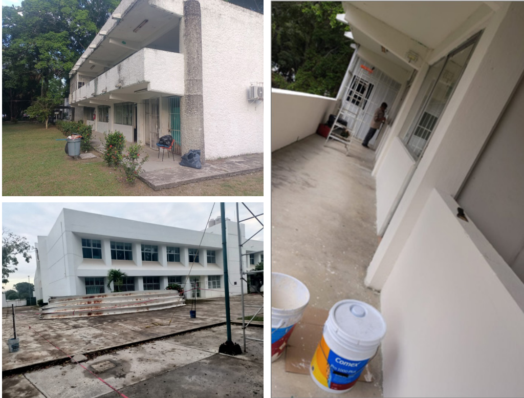
Figura 6. Acciones de limpieza y pintado de edificios.
