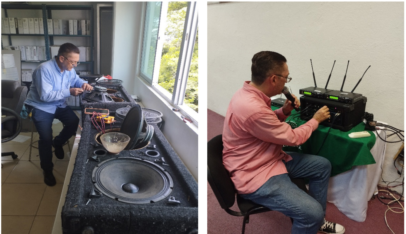
Figura 16. Mantenimiento preventivo al equipo de sonido del Auditorio Alexander Oparin.
