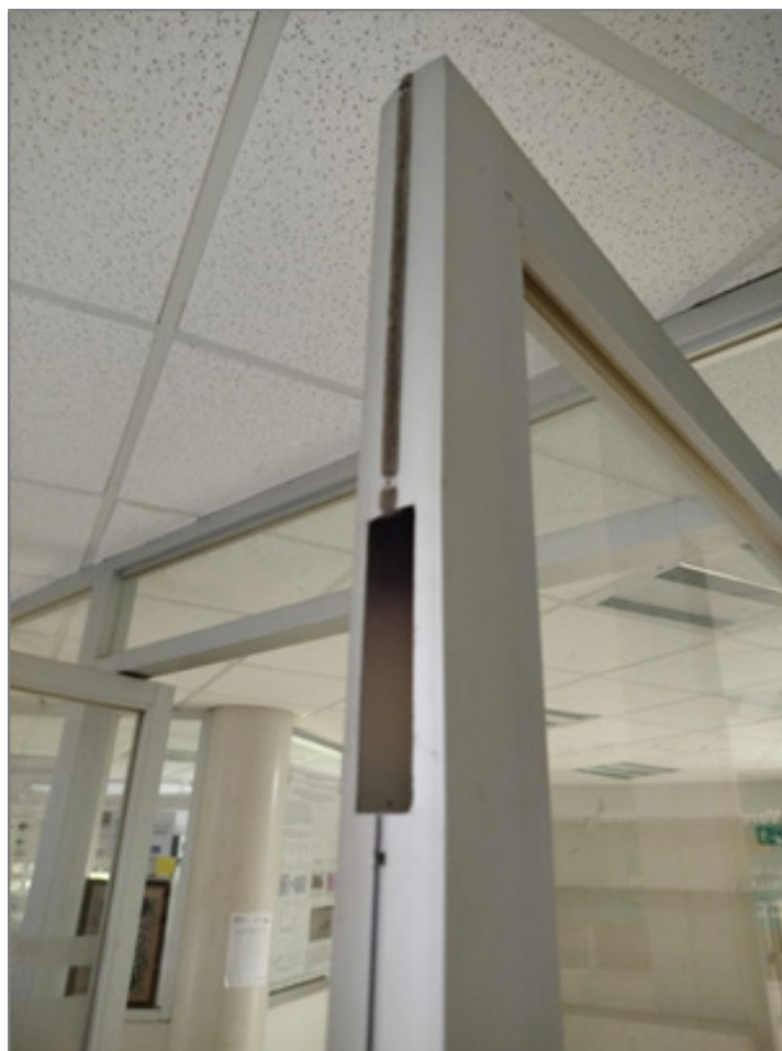
Figura 10. Reparación de cerraduras en instalaciones de la División.
