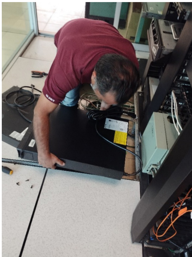
Figura 13. Instalación de una nueva unidad UPS en el SITE principal de red.
