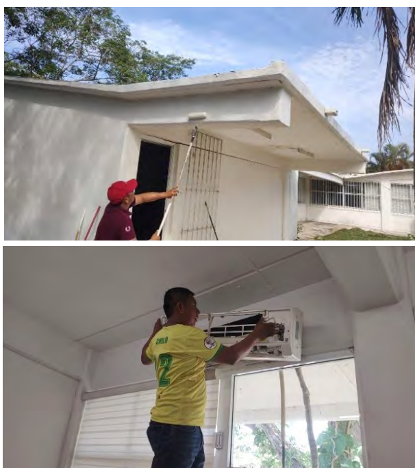
Figura 53. Mantenimiento de la Infraestructura Física
