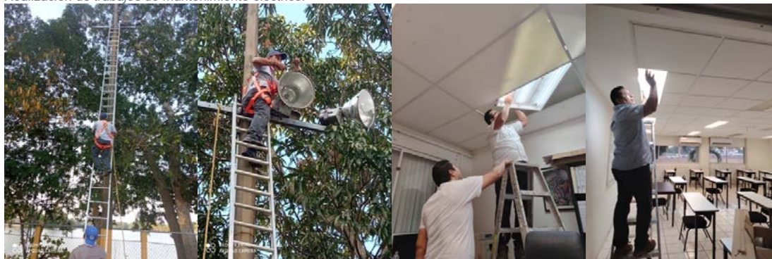
Imagen 5.2 Realización de trabajos de mantenimiento eléctrico.
