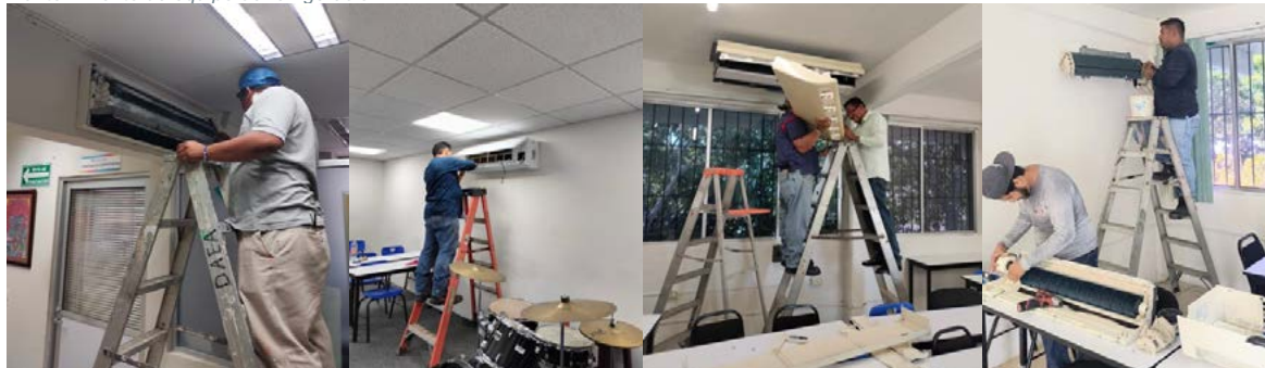
Imagen 5.4 Mantenimiento de equipo de refrigeración.
