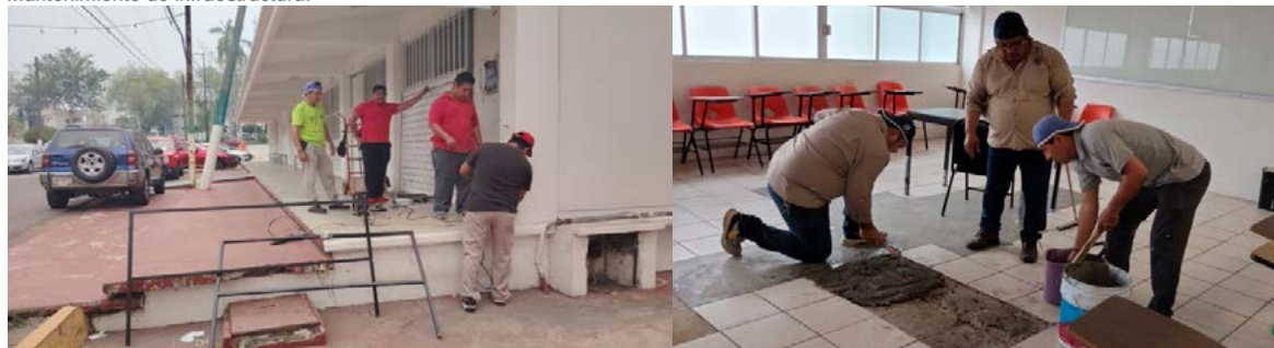
Imagen 5.8 Mantenimiento de infraestructura.
