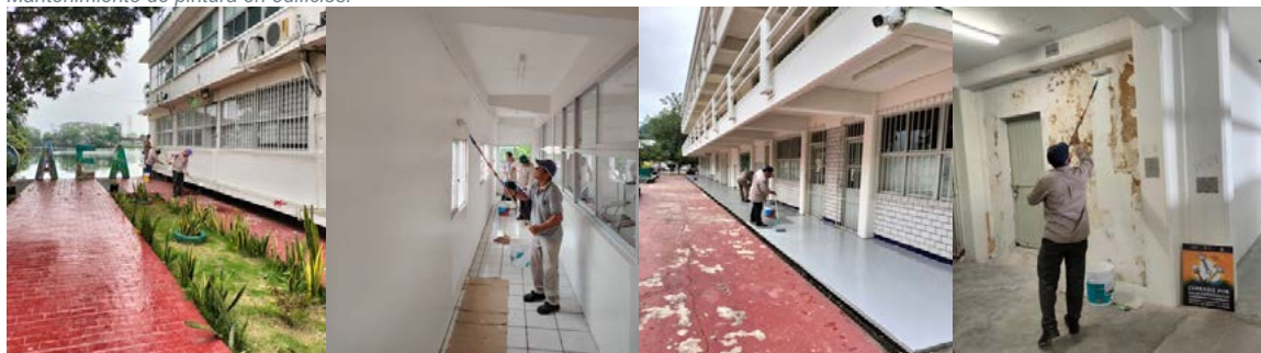
Imagen 5.5 Mantenimiento de pintura en edificios.
