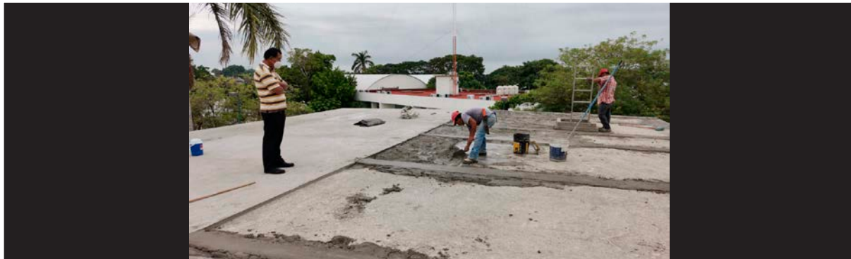
Inicio de trabajos de remodelación en edificio C
