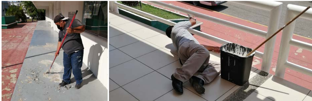
Mantenimiento de pintura exterior en edificio B, D y H
