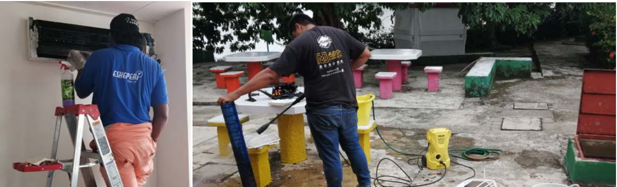
Mantenimiento preventivo y correctivo de aires acondicionados en los edificios A, B, C, D y H
