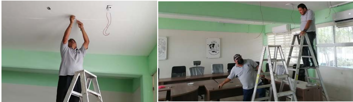
Rehabilitación y acondicionamiento del aula B-1 para convertirla en la Sala de juntas del Consejo Divisional
