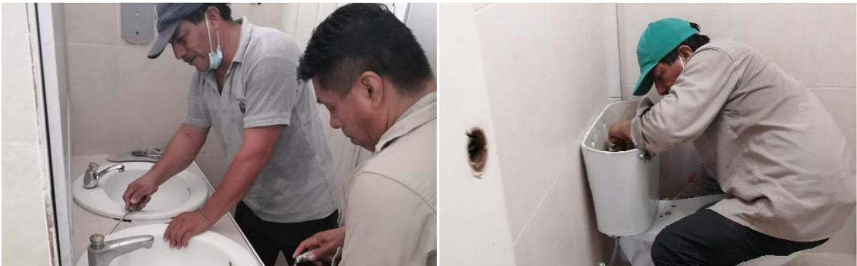
Cambio de llaves en lavabos y juego de herraje de los baños en edificio B
