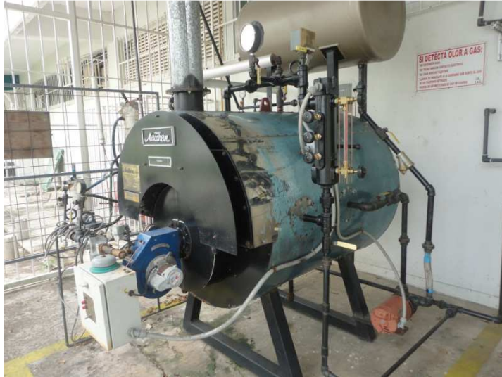
Figura 22. Caldera de vapor.
