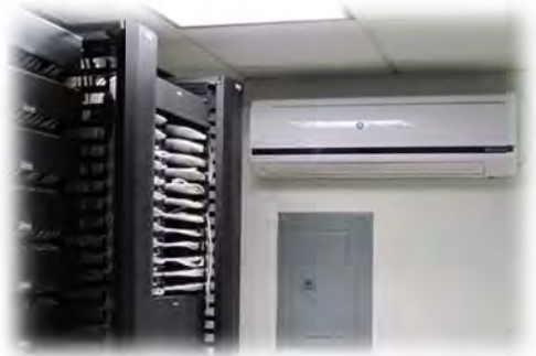
Fotografía 60. Instalación del Aire Acondicionado para el Site Principal
