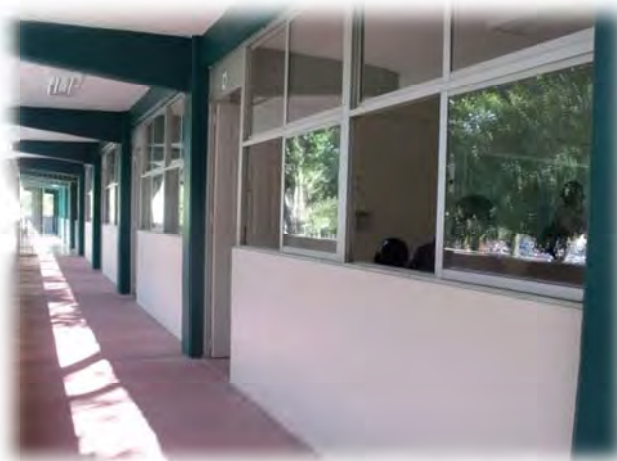
Fotografía 63. Aulas de Docencia Edificio "A"
