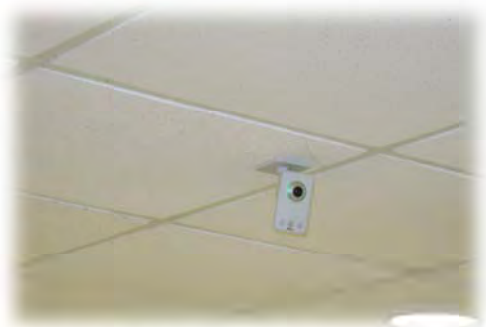
Fotografía 61. Instalación de Cámaras de Seguridad
