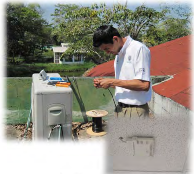
Fotografía 58. Instalación de Accesos Inalámbricos
