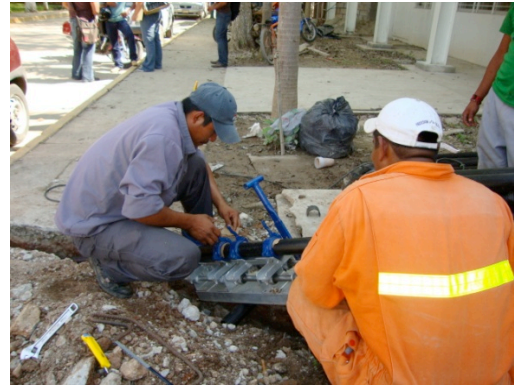
Figura 34. Instalación de red de drenaje
