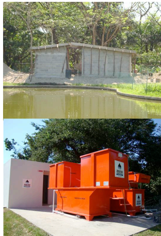
Figura 39. Construcción del área de Psitácidos. Planta de tratamiento de aguas negras.
